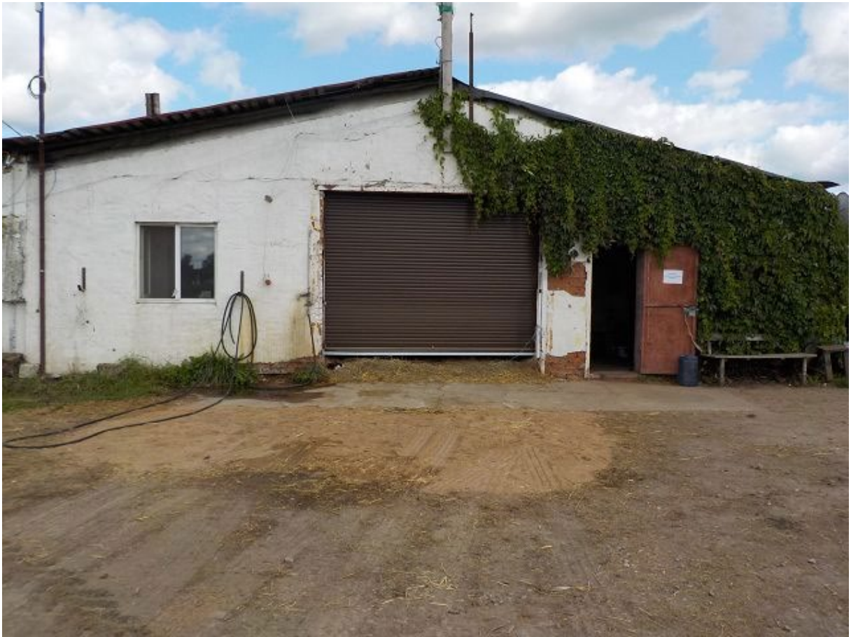
Bild 4: Zugang zum Stall – Station Zyuz´ki
