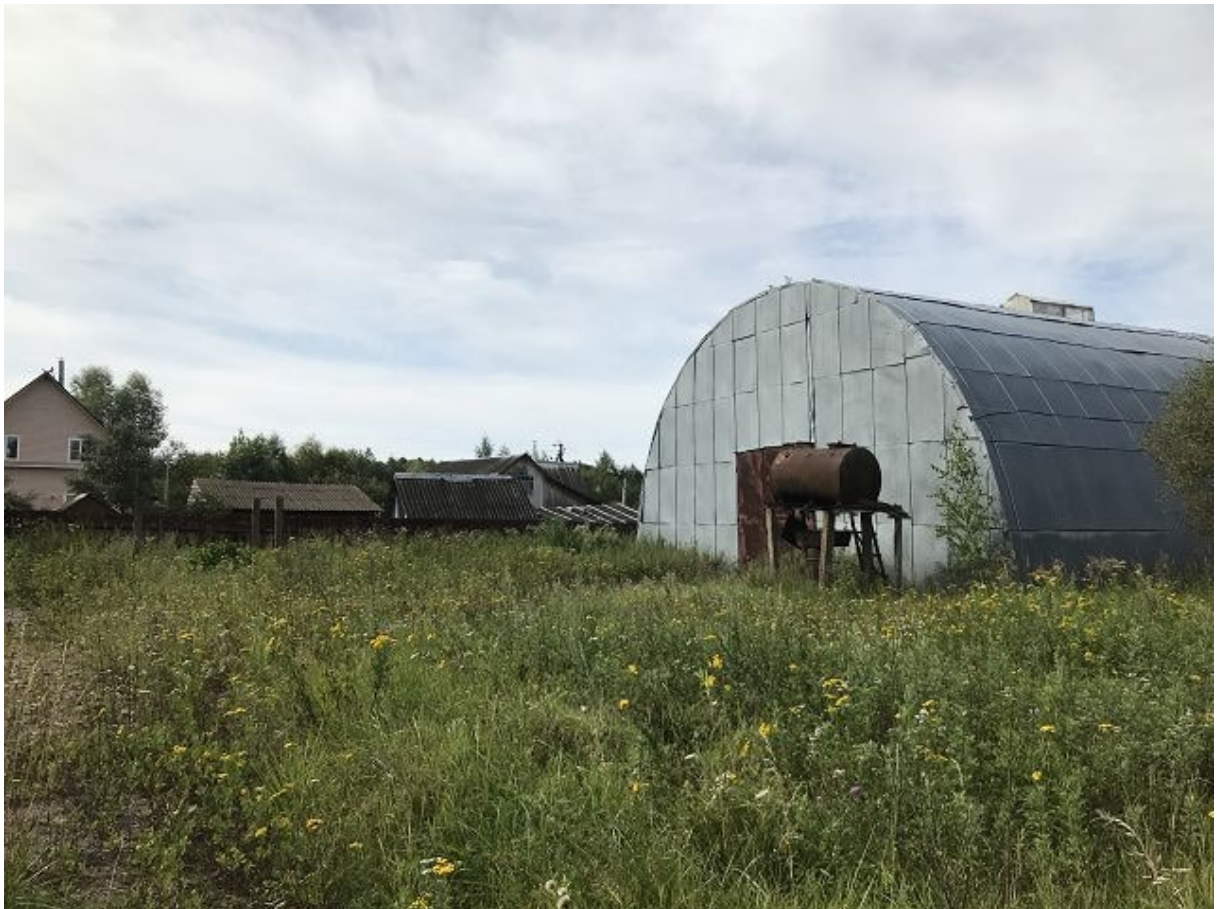
Bild 5: als Stall genutzte Rundhalle – Station Gagarin
