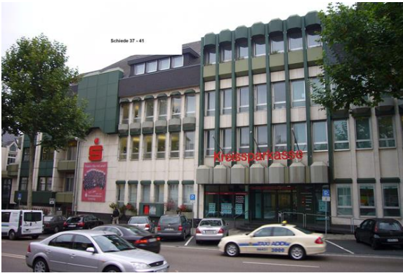
Abb. 9: Standort Schiede II (in Höhe der Hausnummer 37-41)
