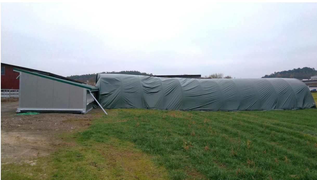
Abb. 2: Kleiner Mobilstall mit einer Erweiterung aus einem Folientunnelgestänge mit Abdeckvlies. Die Frontseite kann mit einem Netz oder Hasendraht verschlossen werden. Zur Versorgung sollte eine Tür eingebaut werden.
