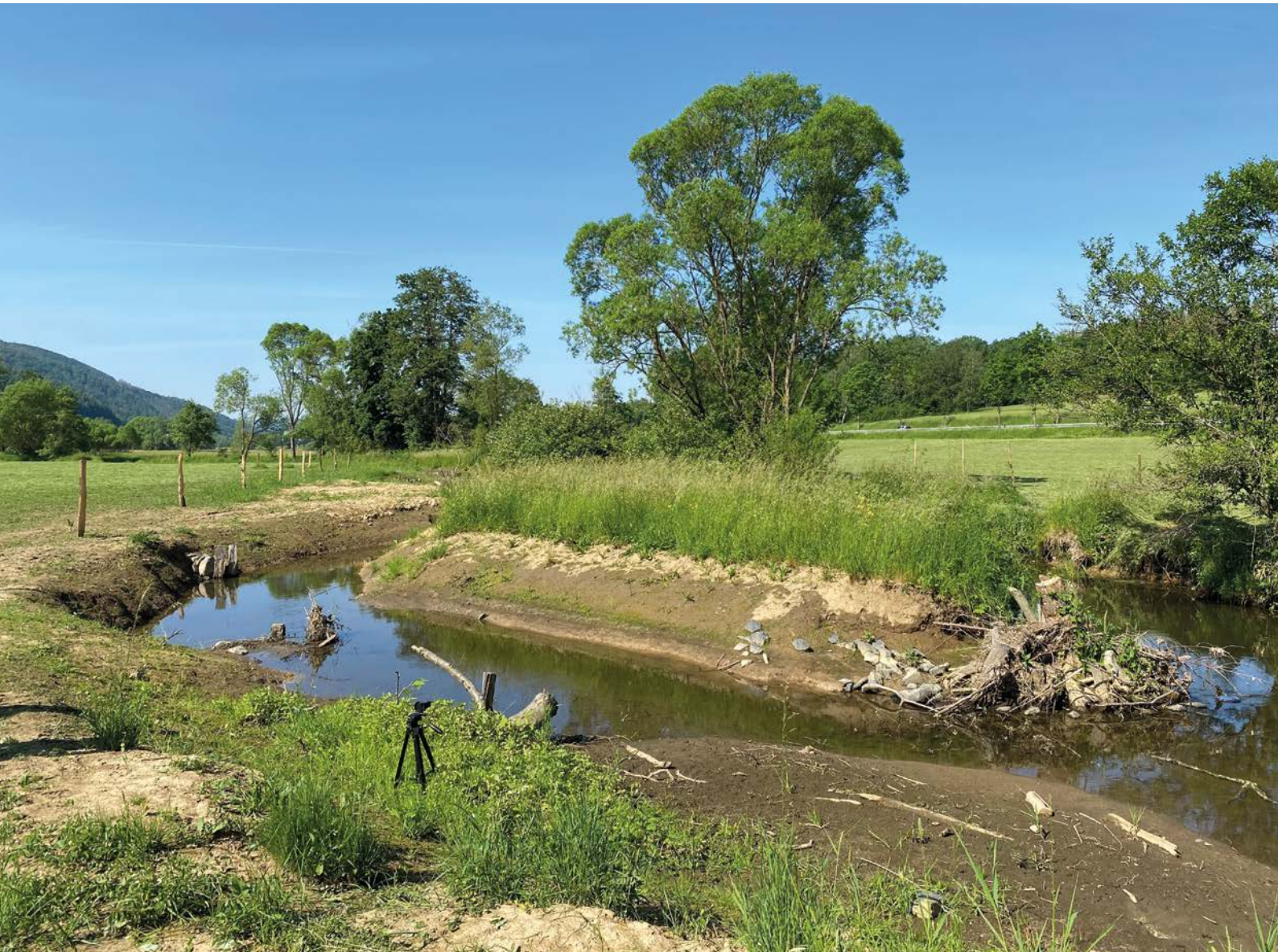
▲ Furkation nach Bauabschluss im Juni 2021
