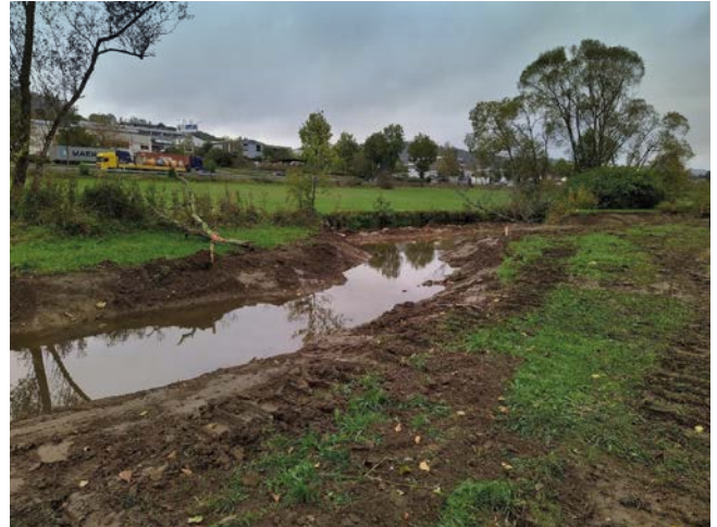
▲ Aufweitung der Dietzhölze in Eschenburg
