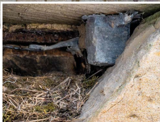
▲ (Abb. oben) Beispiel für eine umsichtige Mauerwerksinstandsetzung am Ehrenmal in Kassel (Abb. links) Nestplatz in der Außenwand der Grotte, Schlosspark Wilhelmsthal
