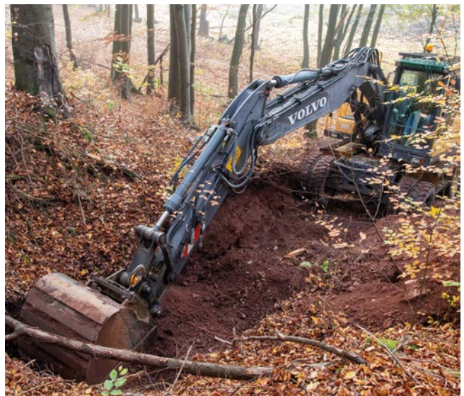
▲ Zur Sicherung des Ölbergstollens war der Einsatz eines Baggers notwendig
