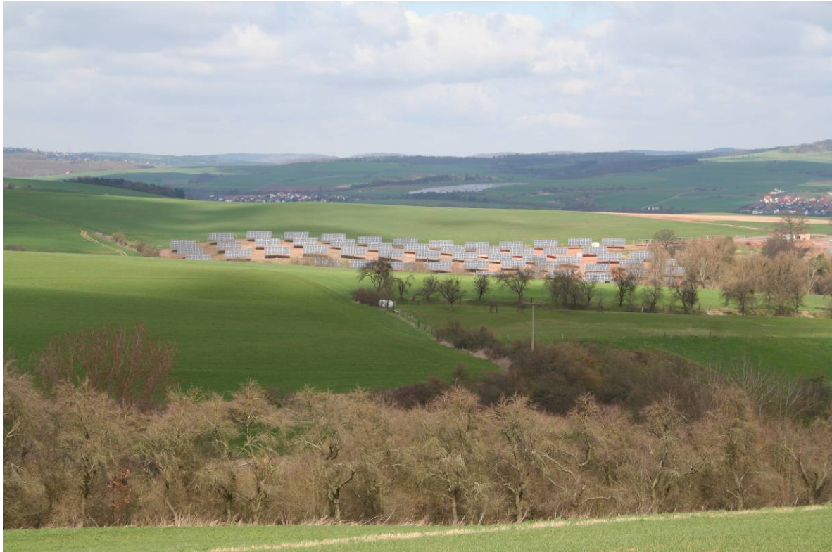
Abb. 6: Photovoltaikanlage im Außenbereich (Foto: Schnittstelle Boden)
